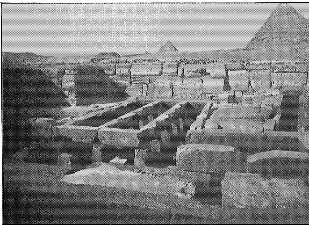
Abb. 14. Das Dach des Torbaus von Nordosten gesehen.
