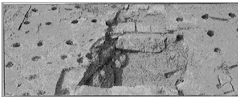
Abb. 68. Löcher im Unterpflaster, in denen Gerüstbäume eingesetzt waren.
