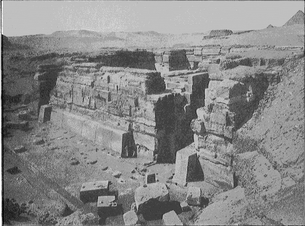
Abb. 21. Die Fassade des Torbaus, heutiger Zustand. Davor die Terrasse.
